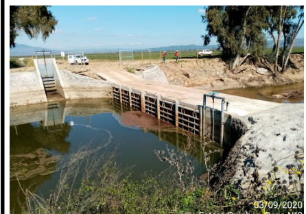
Red de canales Fase III, Poza N°2 en Estero Quiahue
