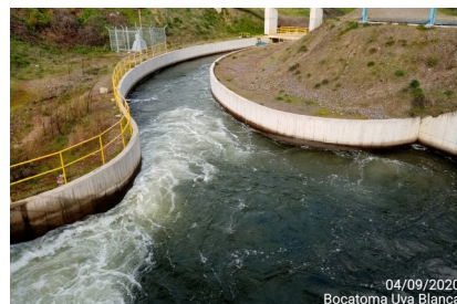
Bocatoma Uva Blanca (Canal Matriz Nilahue Tramo 1).
