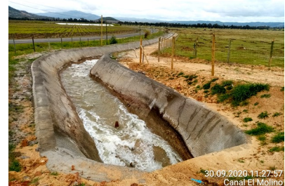
Red de canales Fase III, Canal El Molino.
