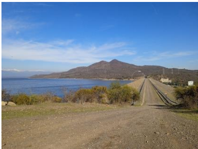
Bocatoma Canal Teno-Chimbarongo
