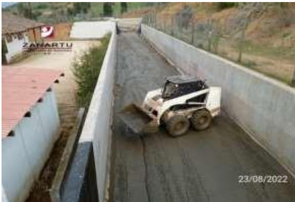
Canal Sur Km 4.400 Inspección de actividades de Conservación.
