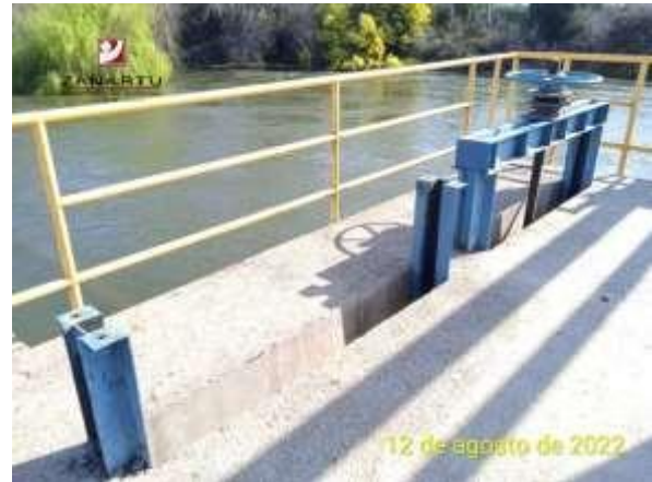
Bocatoma Uva Blanca.
