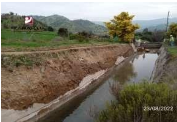
Canal Matriz Nilahue Tramo 2, salida Túnel La Lajuela.
