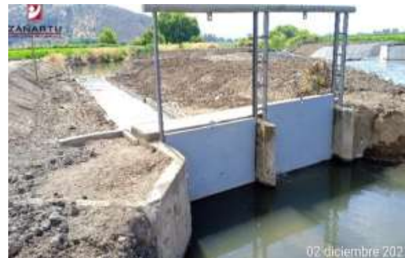
Bocatoma Patagua-Patagüilla, Inspección de obras de Compensación Res. 2056
