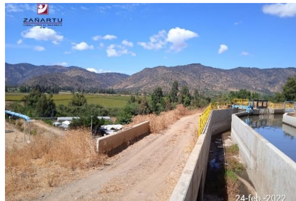
Canal Norte Unificado km 12,40.
