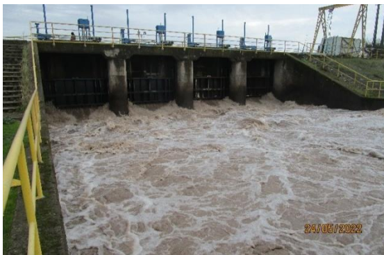
Bocatoma canal Teno-Chimbarongo.
