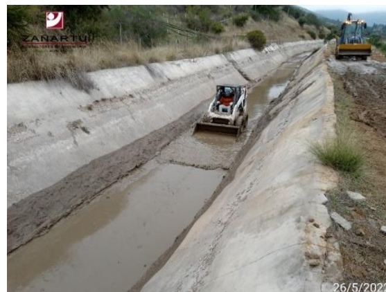
Canal Norte Unificado entre km. 11+600 y 11+980. Limpieza de Canales
