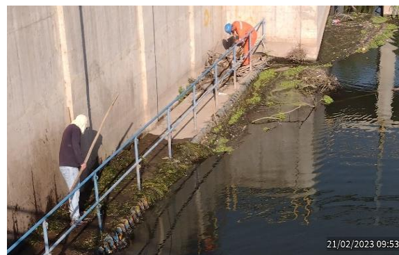
Bocatoma Uva Blanca. Retiro de algas en compuerta de admisión Canal Nilahue 1.
