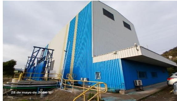
Imagen N°4. Vista general de la Central Hidroeléctrica.
