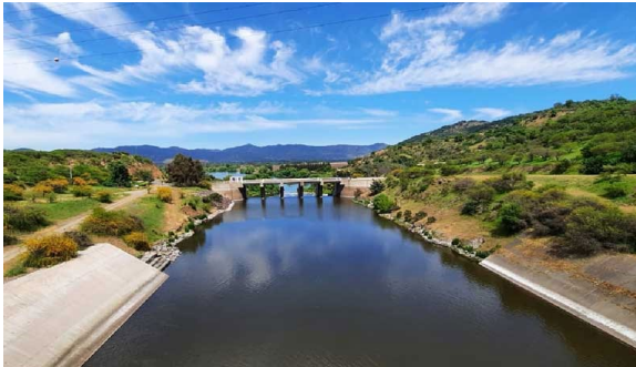
Imagen N°2. Vista general agua abajo desde la Presa Auxiliar.
