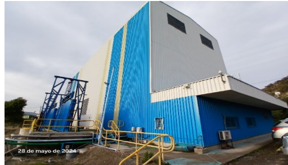
Imagen N°4. Vista general de la Central Hidroeléctrica.
