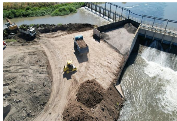
Bocatoma Las Toscas, Área de relleno de maicillo y zona de relleno de material de estabilizados.
