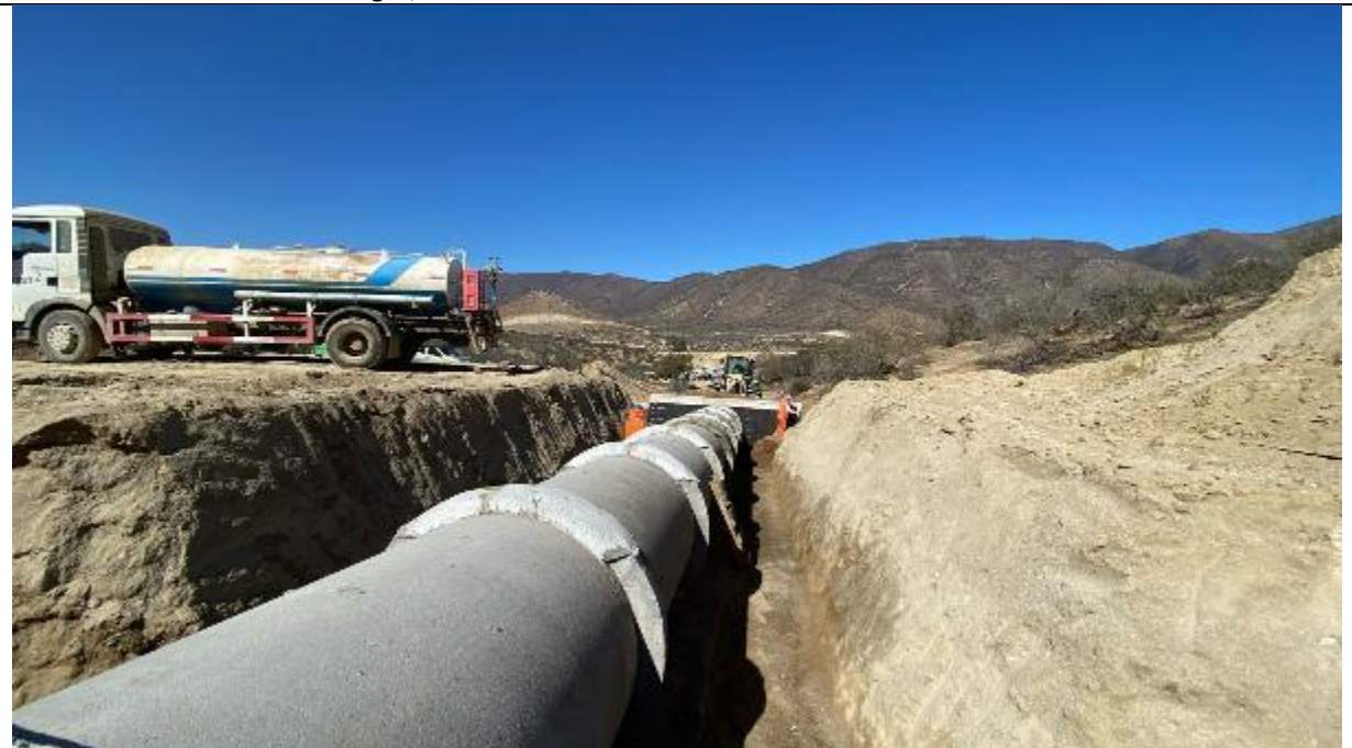
Fig. 2, Rellenos estructurales OA N° 21. Variante Ruta E315
