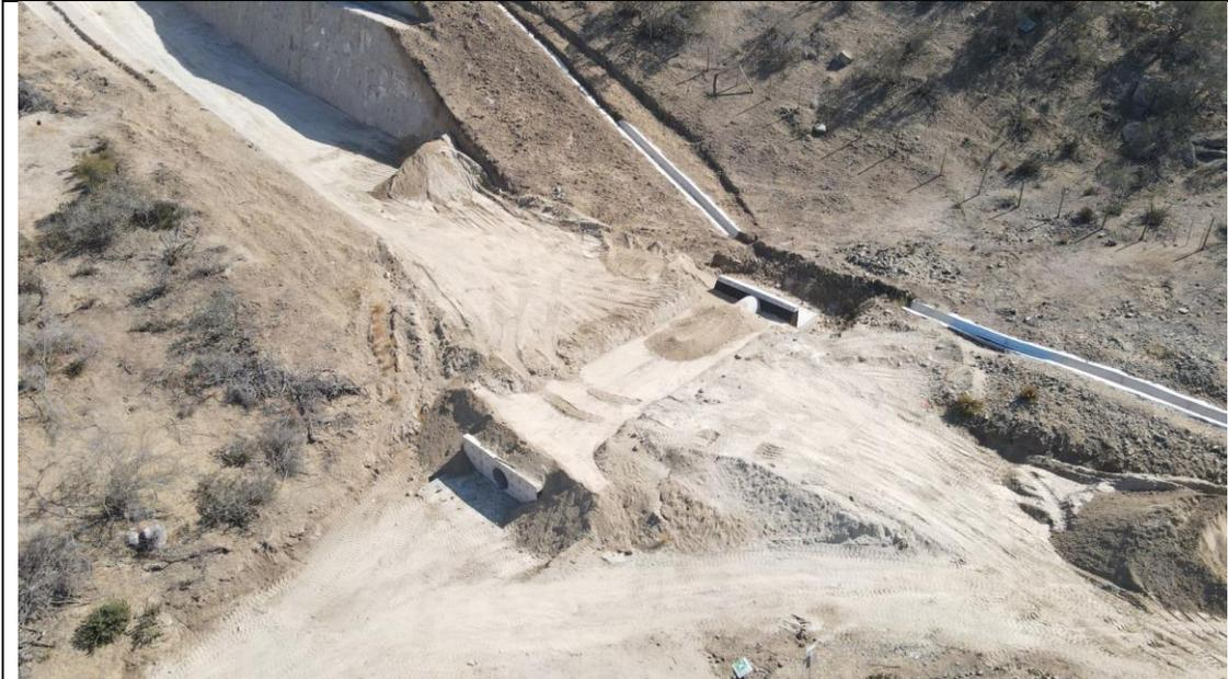
**Fig. 2, Rellenos estructurales OA N° 21. Variante Ruta E315**
