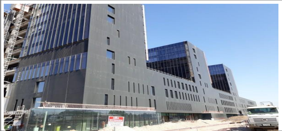
Vista sur oriente de la obra
