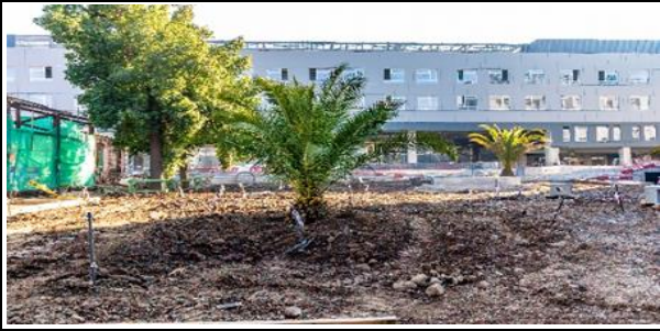
Instalación Palmeras Patio Central
