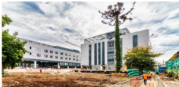
Fachada ING y fachada sur HDS
