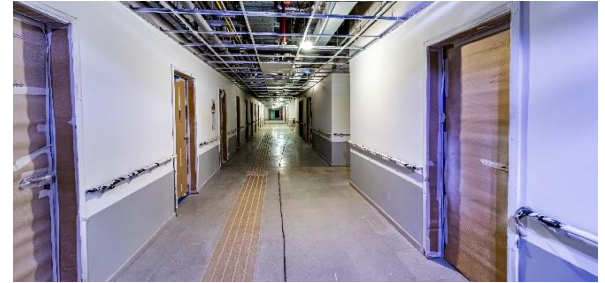
Pasillo interior ING
