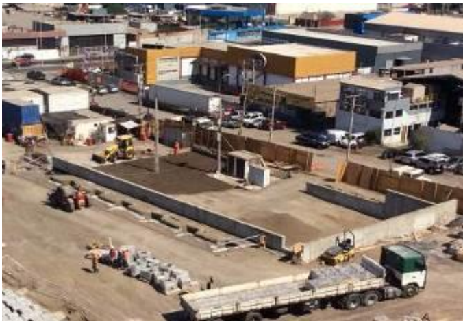
Avance hormigonado de muros multicancha
