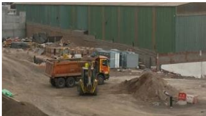
Trabajos en costado noreste del Jardín Infantil
