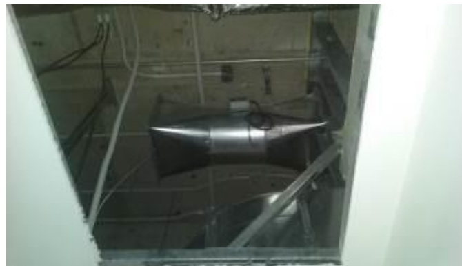
Montaje de ductos y accesorios en salas de aislados en 2do piso UPC
