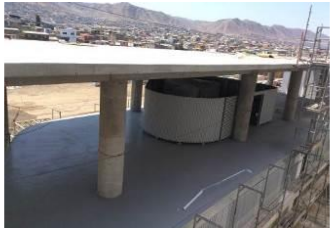
Avance revestimiento de cafetería
