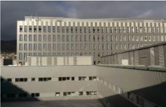
Torre Hospitalización TH
