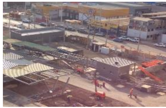
Avance estructura vestidores sector de multicancha
