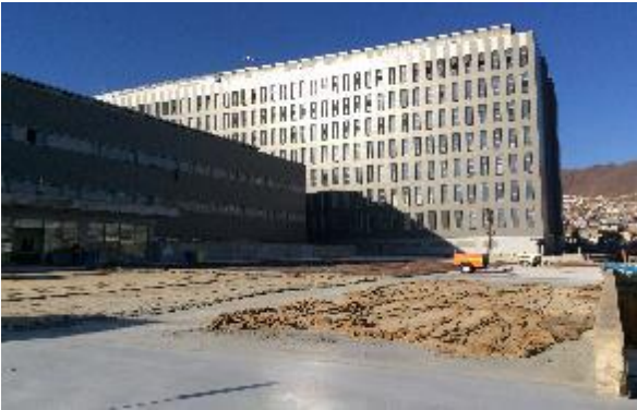
Torre Hospitalización TH
