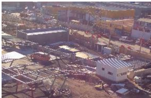
Avance estructura vestidores sector de multicancha
