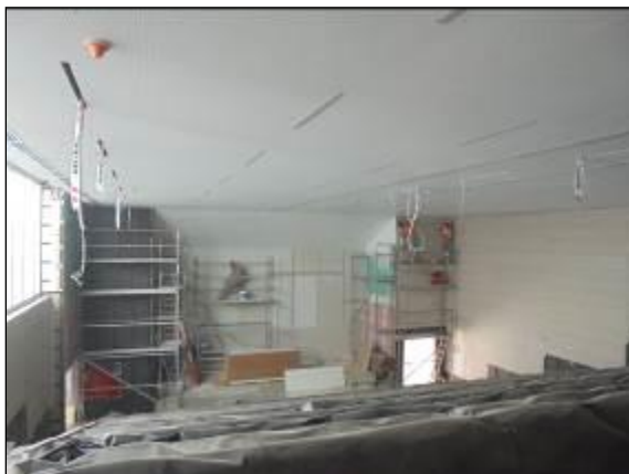
Auditorio en remates de revestimientos
