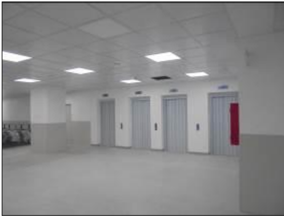
Hall de ascensores, Nivel 2°TH
