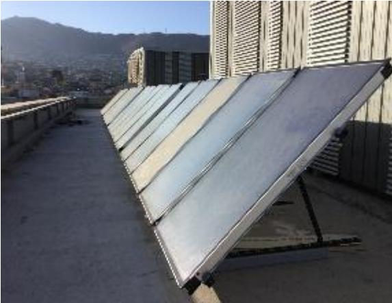
Vista de instalación de 20 paneles solares
