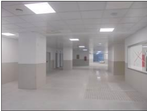
Hall de recepción ascensores 2° nivel
