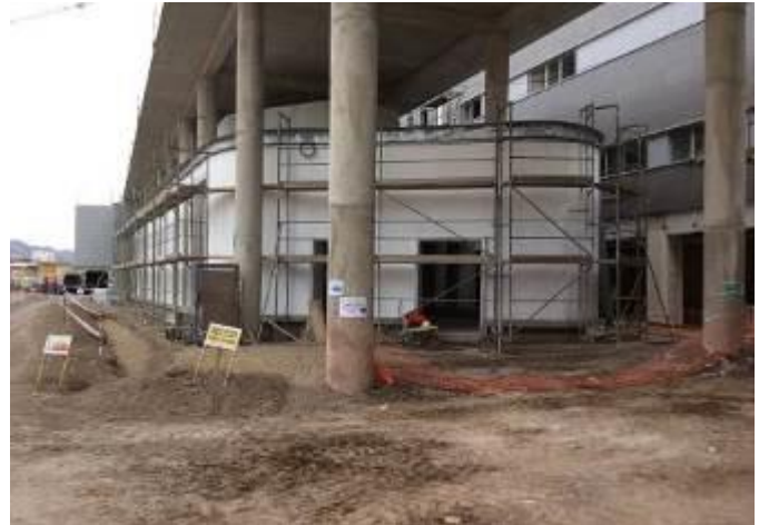
Avance revestimiento de cafetería
