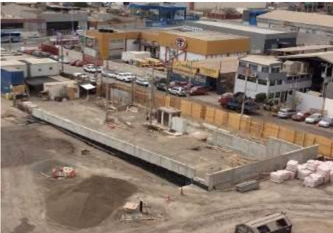
Avance hormigonado de muros multicancha
