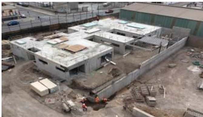
Trabajos en costado noreste del Jardín Infantil
