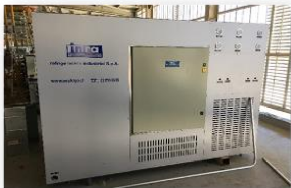
Chiller de aire que se instalara en el piso técnico del edificio UPC
