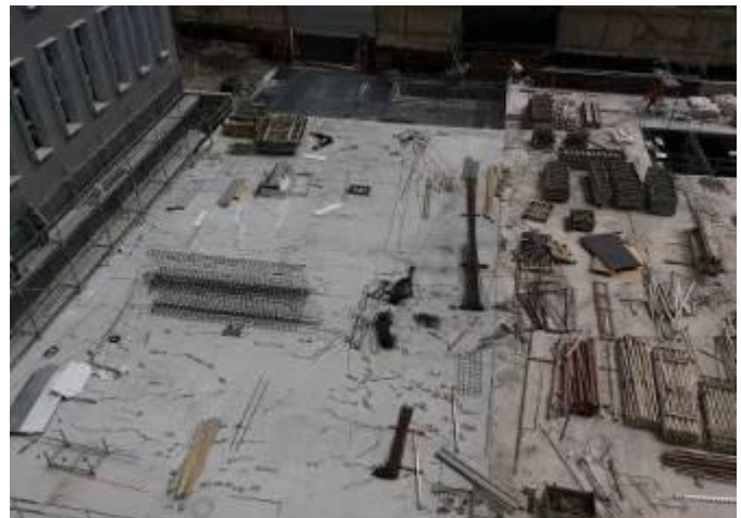
Avance estructura losa de aljibes tramo restante
