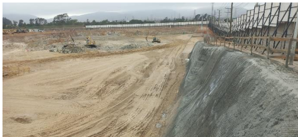
Ejecución excavaciones masivas y mitigaciones acústica
