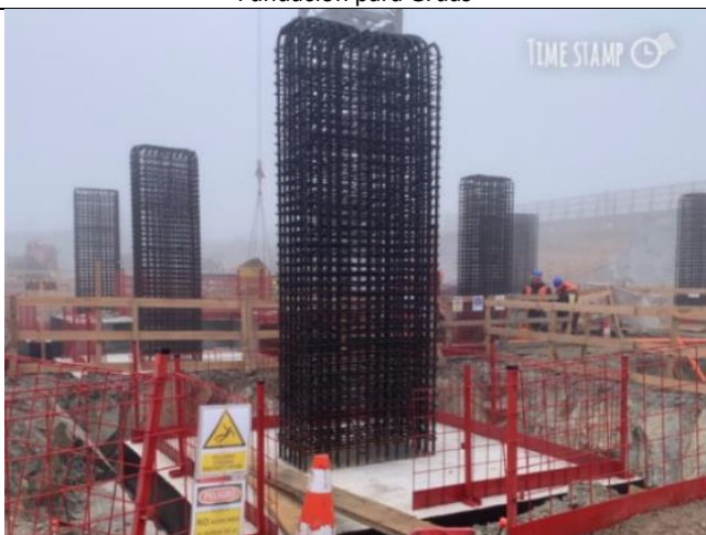
Ejecución de Fundaciones
