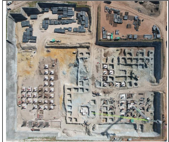
Ejecución de Columnas
