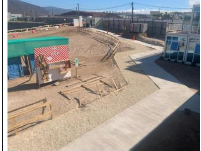
Tránsito interno desde Ingreso de obra a Instalaciones de Faenas
