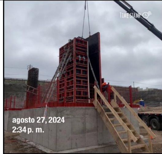
Ejecución de Columnas
