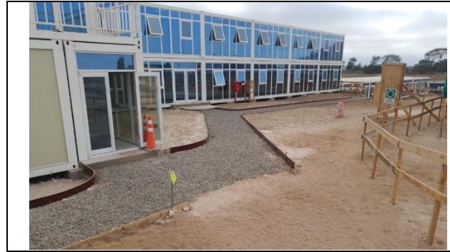
Avance de oficinas de Instalaciones de Faena
