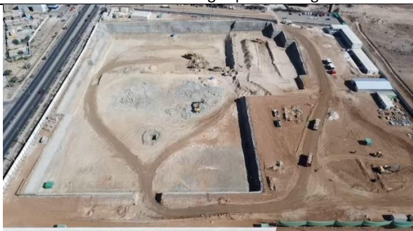
Vista aérea desarrollo de la obra
