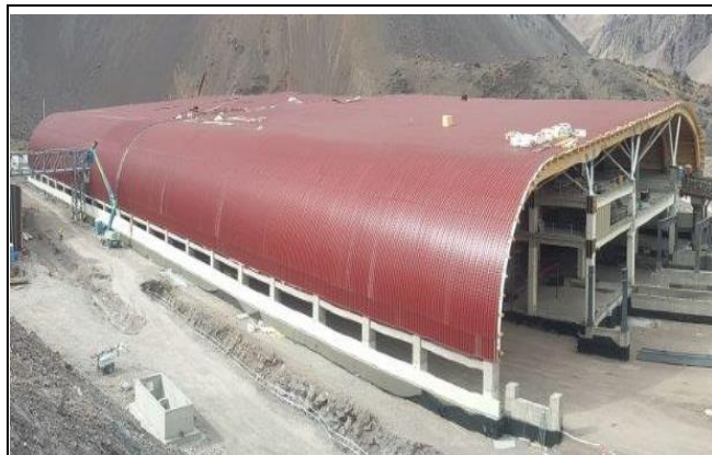
Edificio de Control y Servicios
