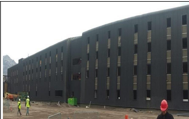
Edificio de Alojamiento de Funcionarios
