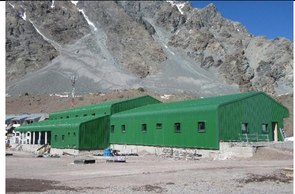
Edificio de Carabineros
