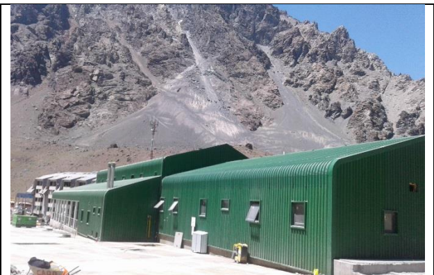
Edificio de Carabineros
