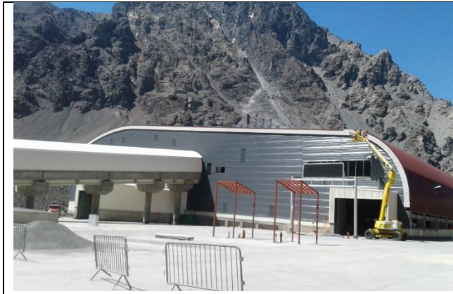
Edificio de Control y Servicios – Vista norte
