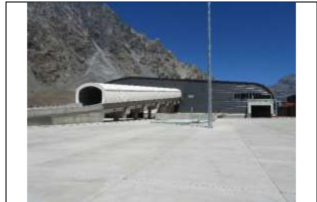
Edificio de Control y Servicios - vista norte
