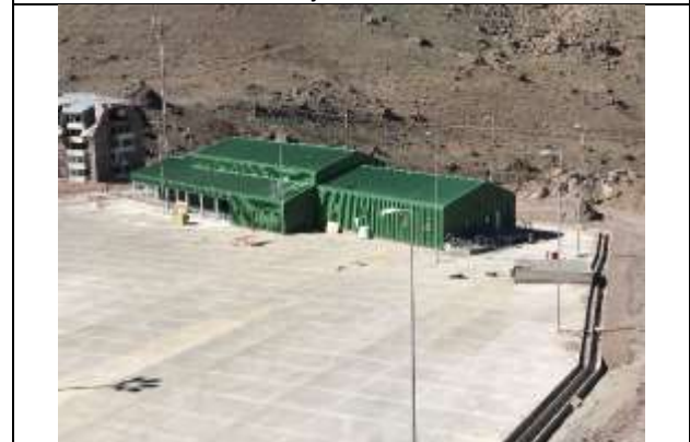
Edificio de Carabineros
