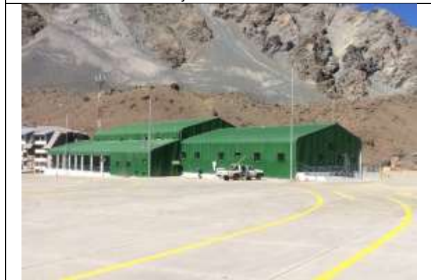
Edificio de Carabineros – vista poniente-oriente
