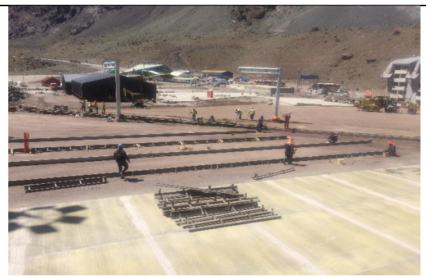
Trabajos en plataforma sur
