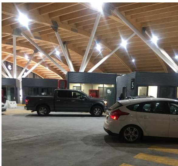
Edificio Control y Servicios – control vehículos livianos
