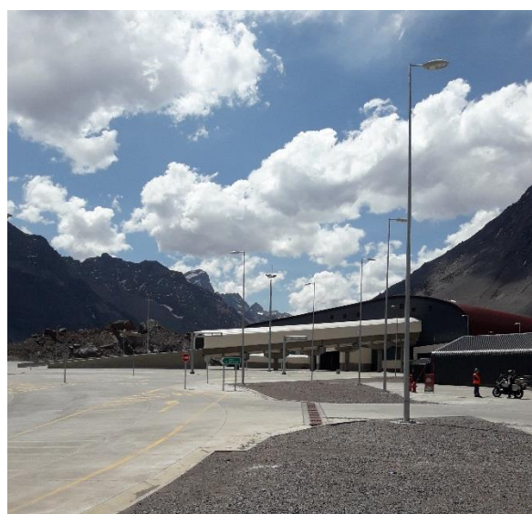
Viaducto ingreso Edificio Control y Servicios
