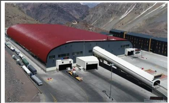
1.- Vista Aérea Costado Norte
