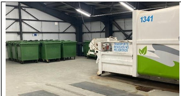
3.- Sala de Compactadores de Residuos.
