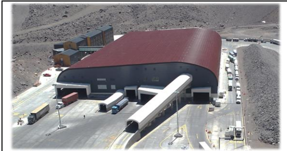
1.- Vista Aérea Instalaciones.
