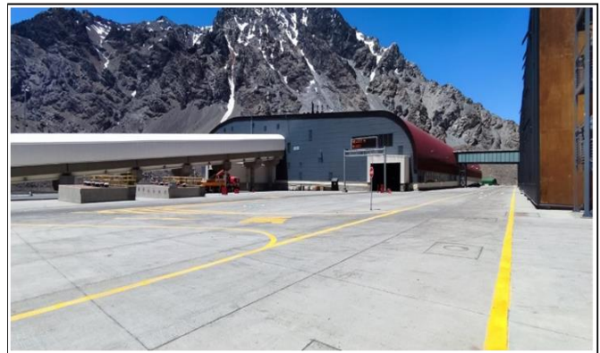
2. Vista Acceso Control Buses
