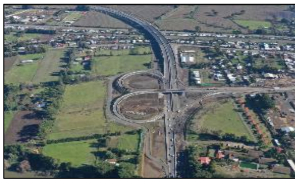
Ilustración N°3: Enlace y Viaducto Coihue
