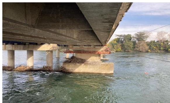
Ilustración N°4: Rehabilitación Puente Coihue
