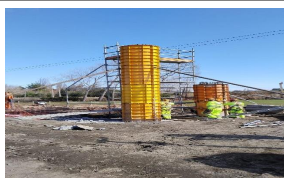
Ilustración N°2: Pasarela Aguada de Cuel
