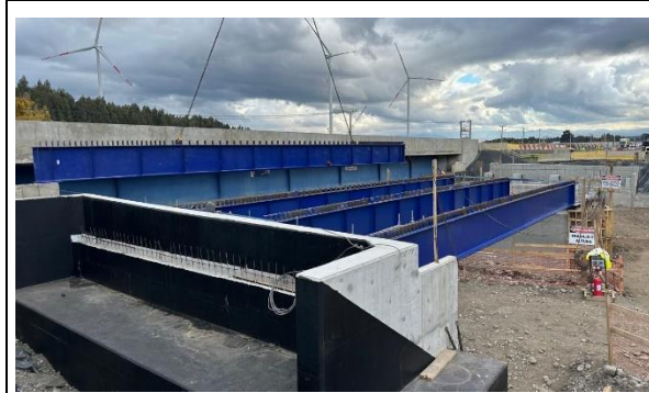
Ilustración N°1: Montaje Vigas Rehabilitación Puente La Suerte
