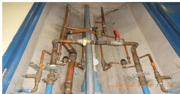
Red de cañerías de agua caliente dentro del shaft entre celdas (Foto N°3)
