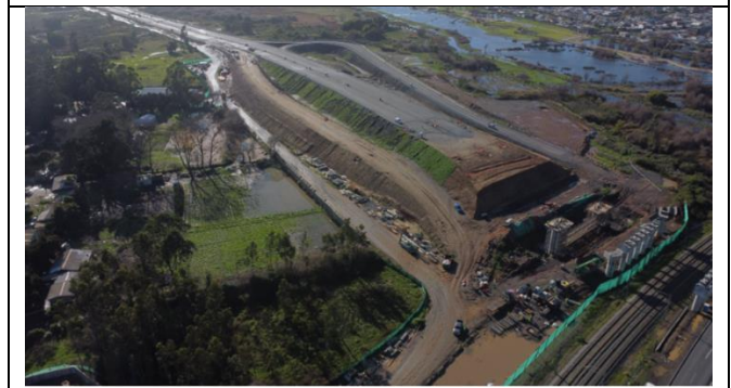
Terraplén Ejes 13, 14, 15 y troncal Sector C (R160)
