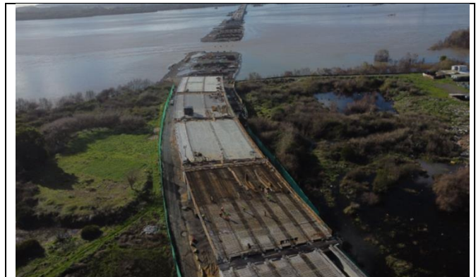
Vista P. Industrial desde Estribo de Salida
