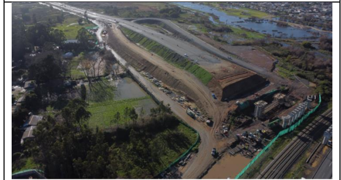
Terraplén Ejes 13, 14, 15 y troncal Sector C(R160)
