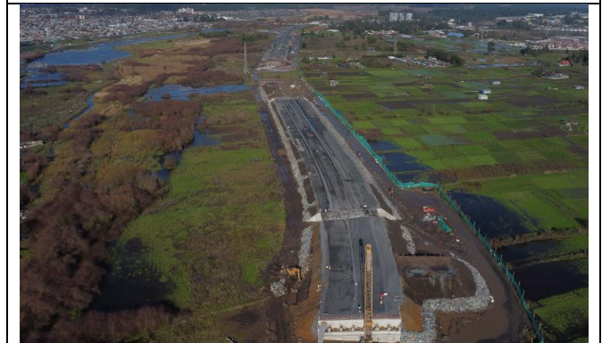
Vista PI desde Estribo de Salida
