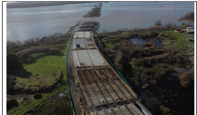
Vista P.Industrial desde Estribo de Salida
