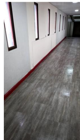
Limpieza de pisos de puentes
