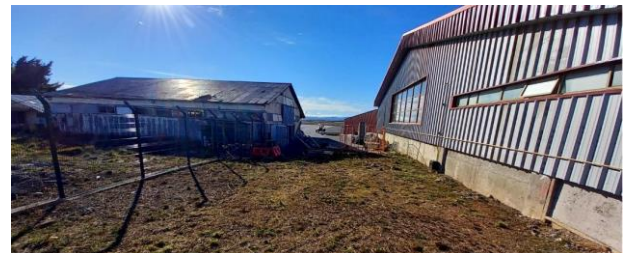
Limpieza sector carga
