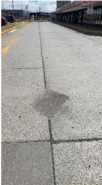
Reparación de pavimento frente a DGAC
