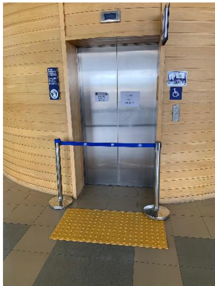
Ascensor hall principal, cambio de rodamientos
