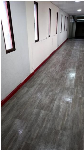
Limpieza de pisos de puentes
