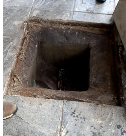
Limpieza y Destape de Alcantarillado
