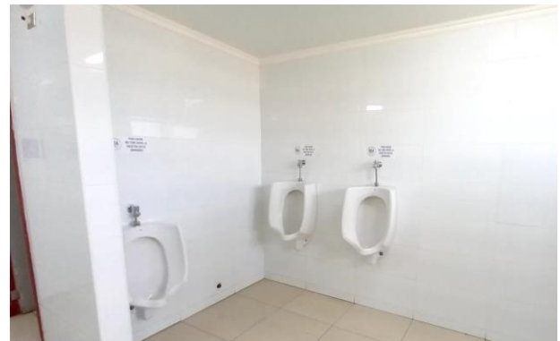
Urinarios sector embarque reparados
