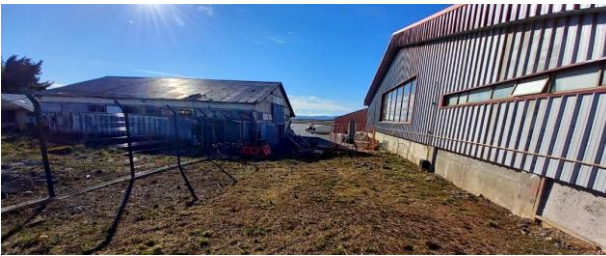
Limpieza sector carga
