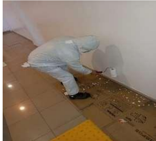
Mantenciones efectuadas, Aeropuerto ítem A-1 MUROS
