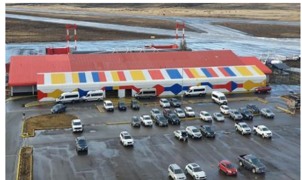
Aeródromo de Balmaceda, sector estacionamiento público.
