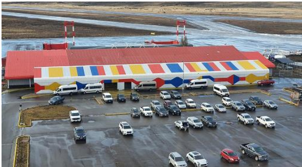
Aeródromo de Balmaceda, sector estacionamiento público.
