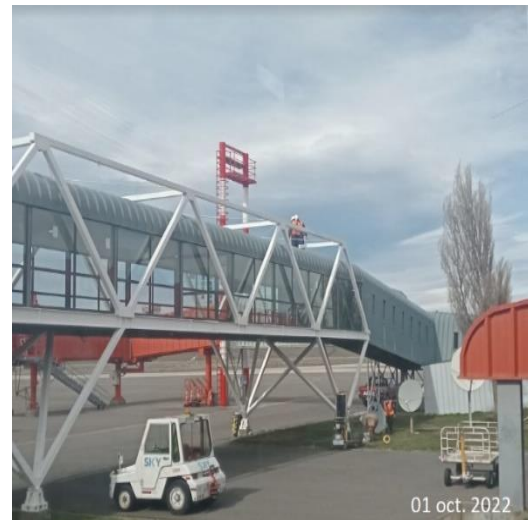
Reparación de Techumbre Puentes de embarque
