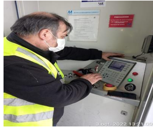
Mantenimiento Puentes de Embarques
