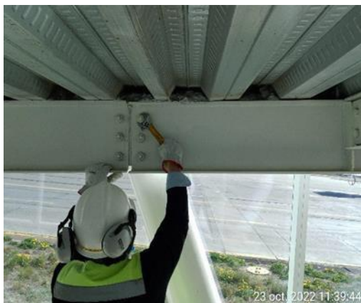
Mantenión estructuras metálicas
