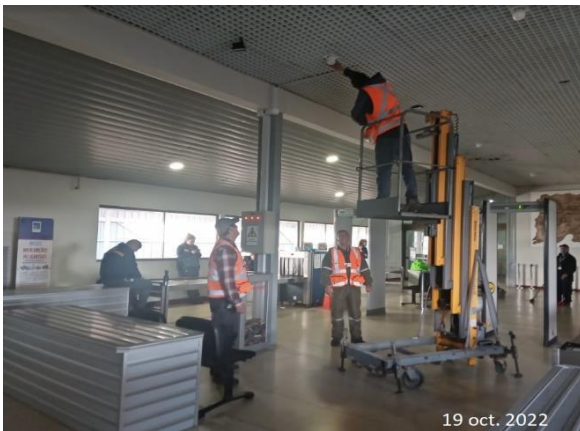
Cambio de luminarias Sector AVSEC
