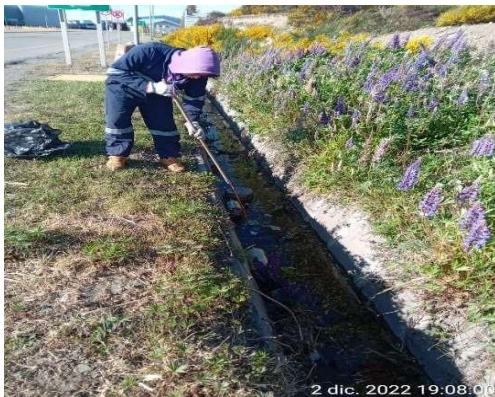
Mantenimiento Drenaje De Aguas Lluvias PUQ
