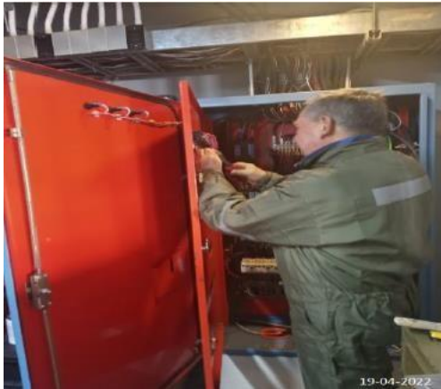
Mantenimiento de Cajas Eléctricas
