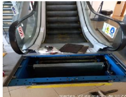
Mantenimiento Escalera Mecánica
