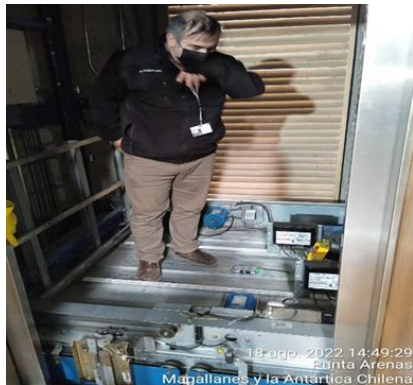
Mantenimiento correctiva Ascensor
