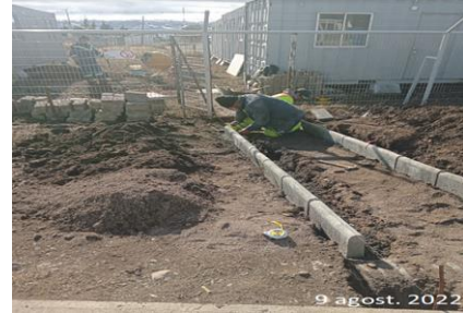
Construcción Pasarela a Container IF
