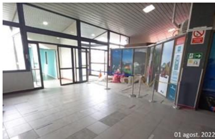
Cambio de cerámicos en terminal
