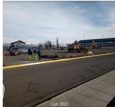
Reparación hundimiento de estacionamiento
